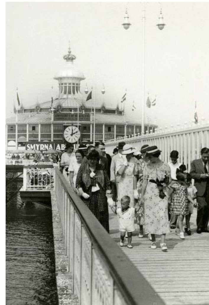
Wandelpaden en vrij zicht aan de zijkanten van de pier
